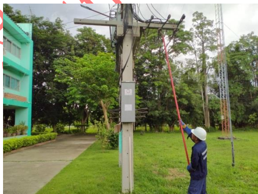
ช่างดำเนินการตัดไฟฟ้าแรงต่ำของอาคารสำนักงาน
